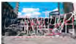
Kunst vorm Bau (4) Zwölf Meter Wut Von Ulrich Amling
